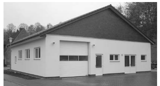
Auf der Zielgeraden: Der Erweiterungsbau des alten Feuerwehrgerätehauses
