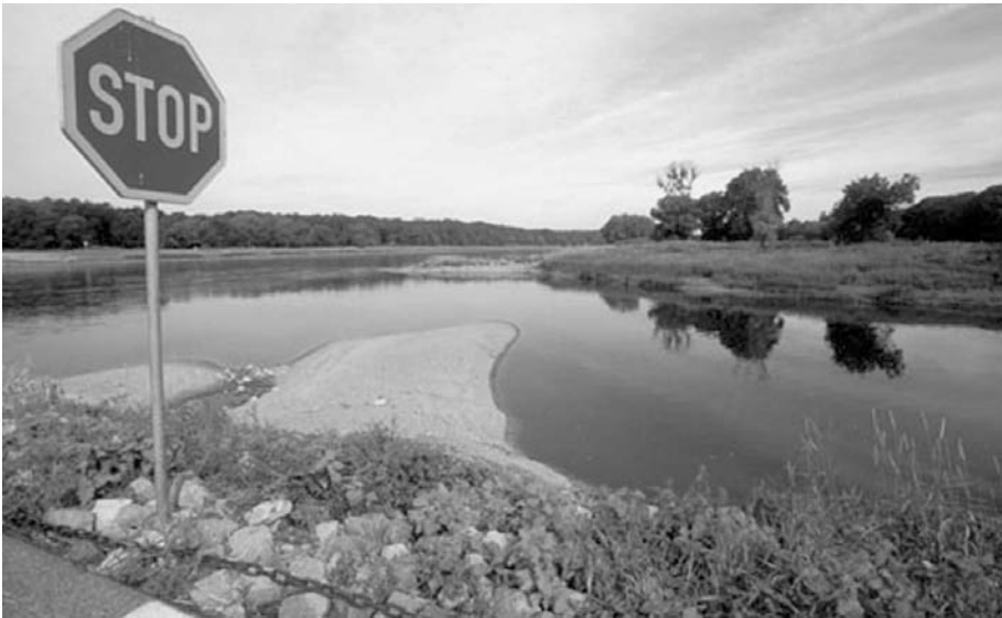
Hochwasserschutz an der Elbe – Hochwasserschutz an der Elbe bei Breitenhagen (Copyright: BMU / transit / Härtrich)
