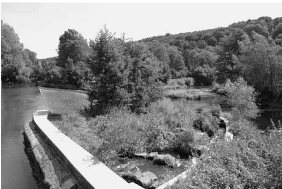
Wasserkraftwerk in Trendelburg - Über die Fischtreppe finden die Fische zurück in den Flusslauf (Copyright: BMU / Bernd Müller)
