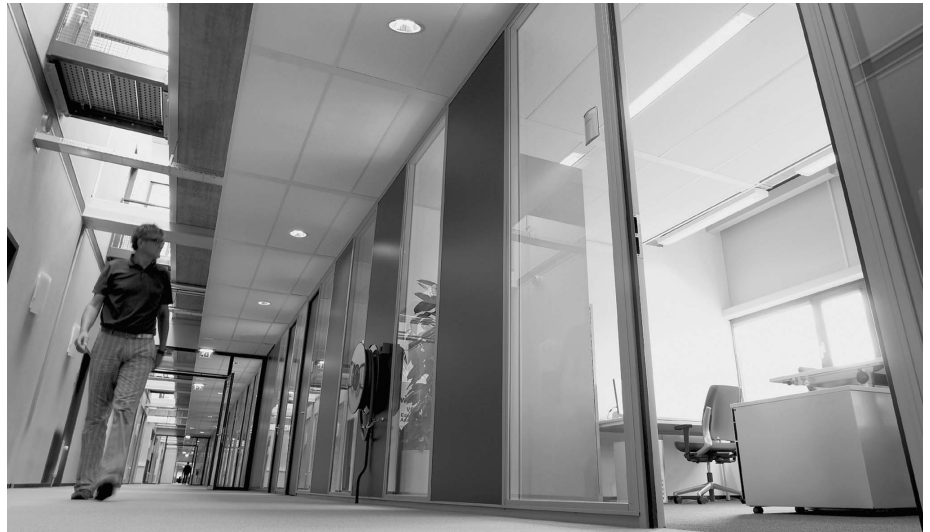
In Bürogebäuden hilft Lichtmanagement beim Stromsparen. Zum Beispiel kann Flurlicht per Sensor aktiviert werden, sobald jemand den Flur betritt. Eine Dauerbeleuchtung wird überflüssig. Foto: licht.de
