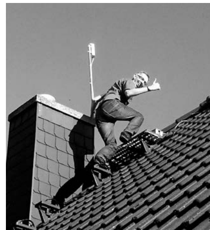
Freifunker bei einer Router-Installation im ländlichen Raum, Bildrechte: Frank Radzio
