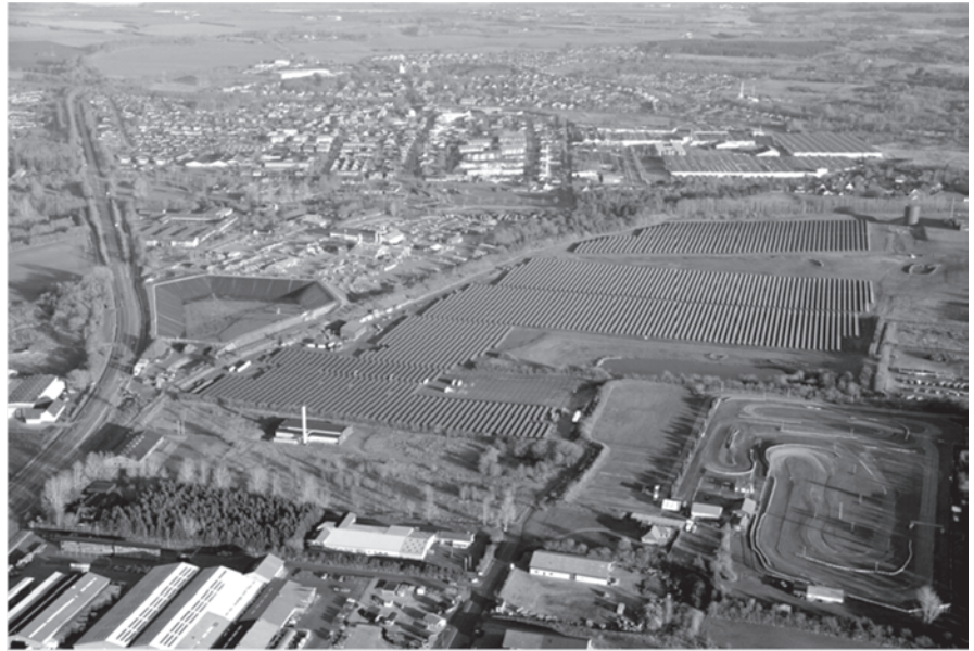
Übersicht der solarthermischen Anlage mit Erdbeckenspeicher in Vojens (DK) (Quelle : http://www.vojensfjernvarme.dk/firmaprofil/billeder-fra-solvarme-etape-ii )
