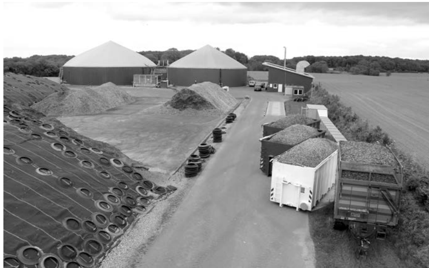
Die Biogasanlage in Sterup, auch zur Trocknung v. Holz hackschnitzeln
