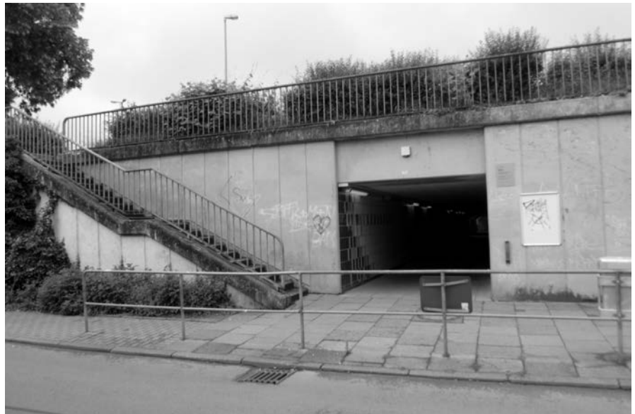
Bahnhof Büchen, Eingang Ostseite
