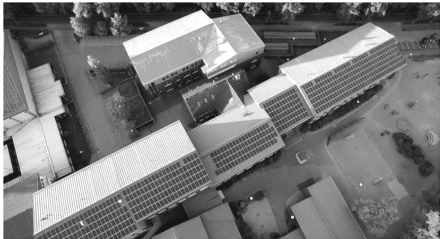
Abb. 4: Schulzentrum Büchen mit Photovoltaikanlage
