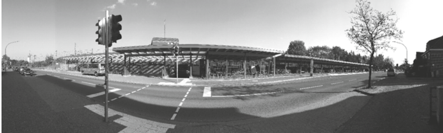
Abb. 2: bereits fertig gestellter Bereich der Mobilitätsdrehscheibe (Bahnhofseite Lauenburger Straße)
