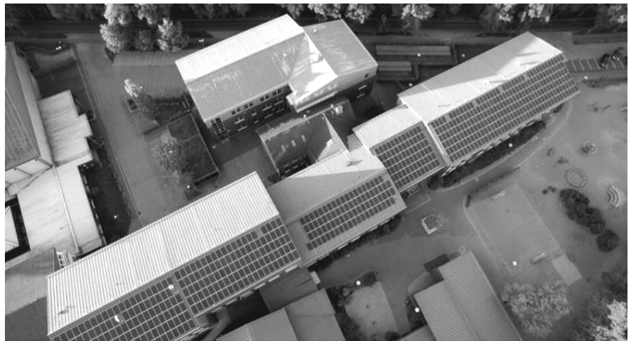
Abb. 4: Schulzentrum Büchen mit Photovoltaikanlage
