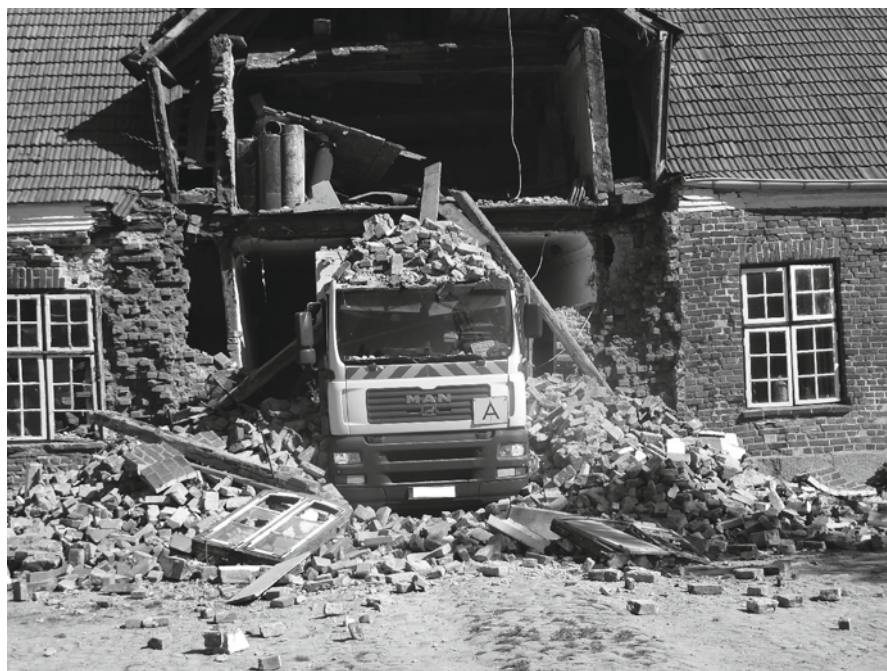
Kraftfahrzeug-Haftpflichtversicherung: Müllfahrzeug verursacht einen großen Gebäudeschaden
