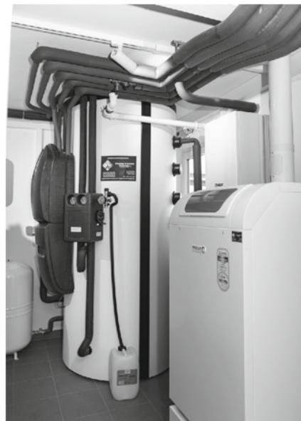
Abbildung 6 Hybridheizungen nutzen zur Wärmeversorgung von Gebäuden unterschiedliche Energien. Foto: WuW/IWO
