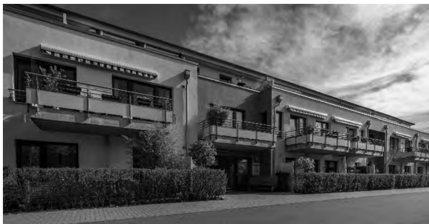
Das Haus der Bau- und Wohnungsgenossenschaft Fahrenkrug e.G. bietet auf 3 Ebenen 31 seniorengerechte Wohnungen mit Fahrstuhl
