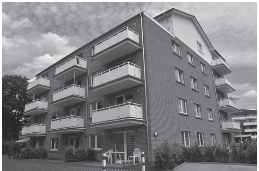
75 geförderte Wohneinheiten im Quartier „Am alten Sportplatz“ in Uetersen Foto: ARGE eV (Bauherr: Gemeinnützige Bau- und Siedlungsgenossenschaft Pinnau eG)
