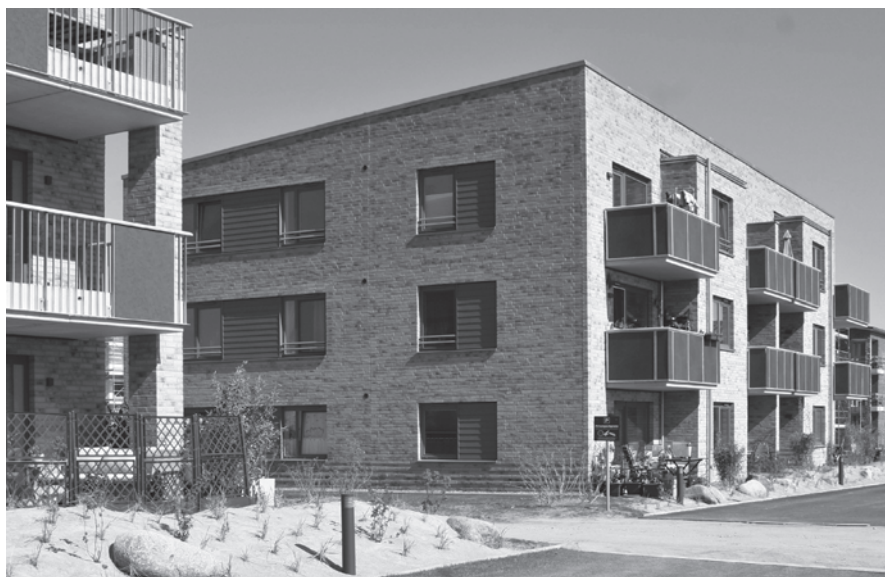
12 geförderte Wohneinheiten im Schmetterlingsweg in Laboe Foto: ARGE eV (Bauherr: Steinert Hafenkantor GmbH)
