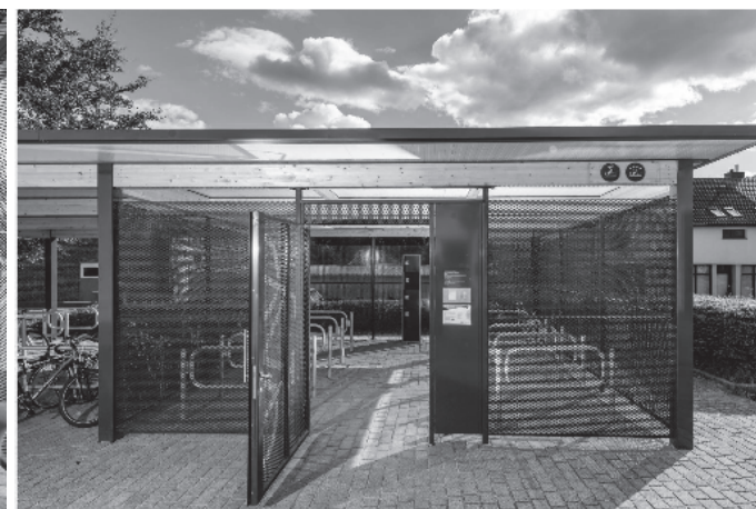
Außenansicht einer kleineren B+R-Anlage. Foto: NAH.SH GmbH/ Manuel Weber
