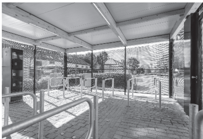
Innenansicht einer kleineren B+R-Anlage im NAH.SH-Design. Foto: NAH.SH GmbH/ Manuel Weber
