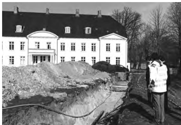
Verlegung des Wärmenetzes auf dem Gelände der Stiftung Louisenlund (Foto: get|2|energy)
