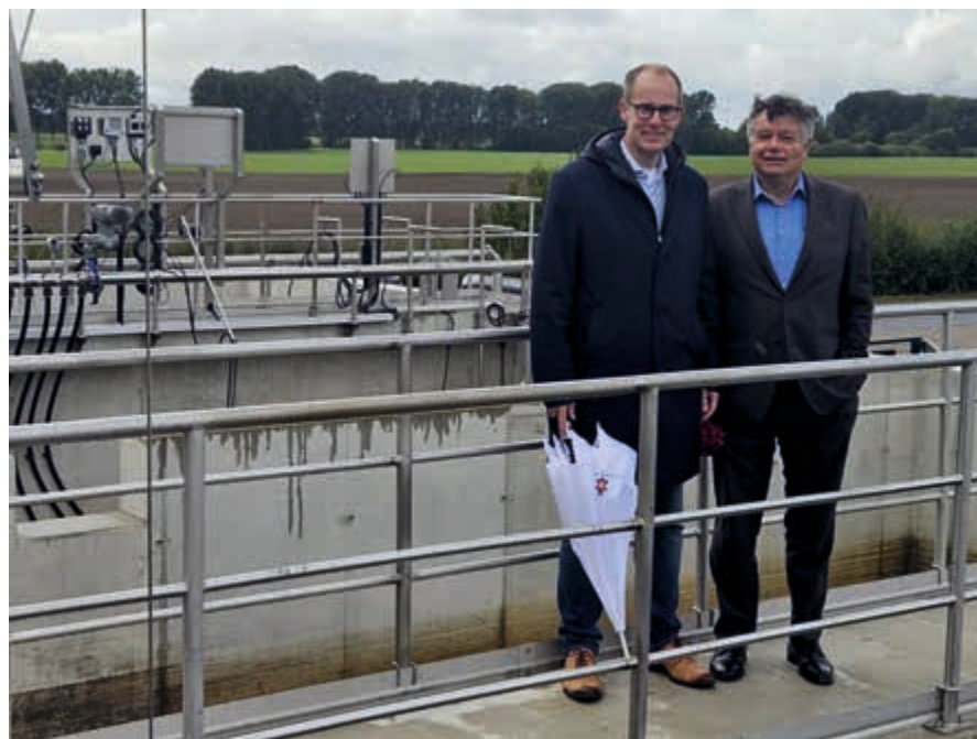
Das neue Klärschlammbehandlungswerk in Steinhorst ist seit Mitte September 2025 in Betrieb. Foto: Jan Rexin
