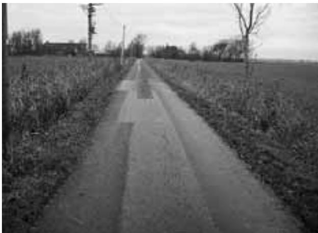
Hinsichtlich der Befestigung dominiert Asphalt mit 91% (13,65 km). Als zweite Befestigungsform findet man in Welt mit 9% (1,36 km) Betonspurbahnen, vielfach noch als „Siemens-Platte“ ausgebildet. 2007 wurde eine Betonspurbahn in der Gemeinde komplett neu gebaut und dadurch auf das aktuell verwendete Maß von 100 – 100 – 100 gebracht.
